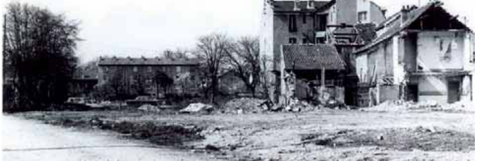
Chantier de démolition (1965) avec en arrière plan, le boulevard Carnot.
